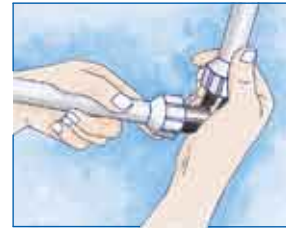
2. Schieben Sie das Rohrende bis zum Anschlag in das Anschlussstück, und ziehen Sie die Überwurfmutter
